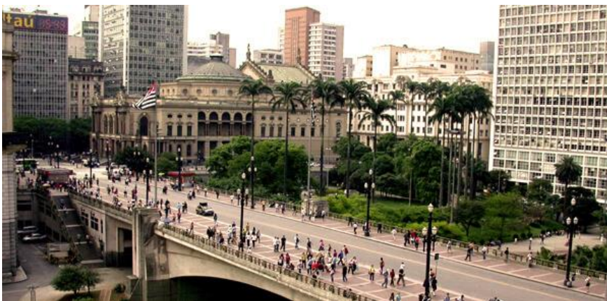
FOTO DO VIADUTO DO CHÁ, EM SÃO PAULO, EM 2011.
