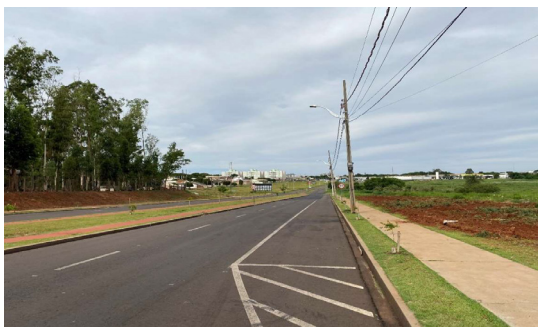
Imagem 21 – Iluminação pública em frente ao local do futuro empreendimento.
