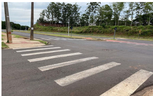
Imagem 25 – Pavimento e sinalização em bom estado de conservação a frente do empreendimento
