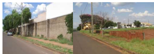
Figura 48. Presença de calçamento na Av. Ilha do Mel, mas sem sinalização podotátil. Fonte: Master Ambiental, 2022.
