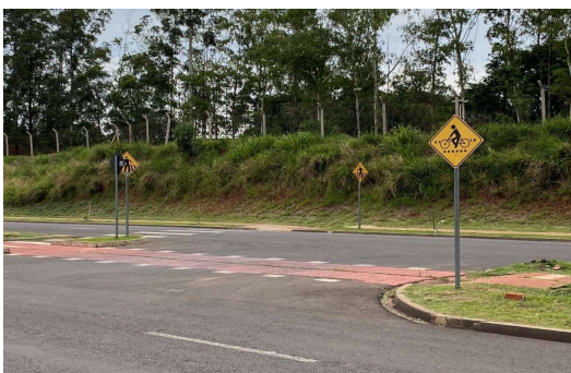
Imagem 27 – Pavimento e sinalização em bom estado de conservação a frente do empreendimento
