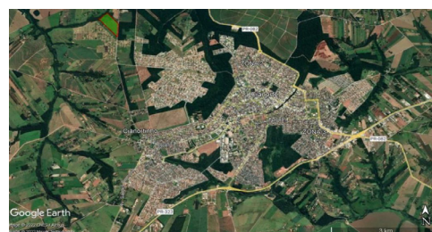
FIGURA 1: Imagem de satélite para a região de interesse. Fonte: Google Earth. Organização: Sanegeo Engenharia.
