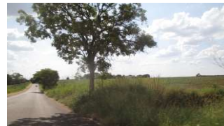
Figura 43. Ausência de calçamento na Av. Atlântica. Fonte: Master Ambiental, 2022.
