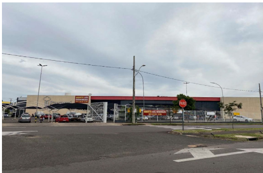
Imagem 13 – Supermercado à 700 m do local do futuro empreendimento.
