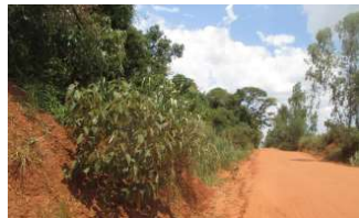
Figura 41. Trecho do prolongamento da Av. Europa com ausência de calçamento. Fonte: Master Ambiental, 2022.
