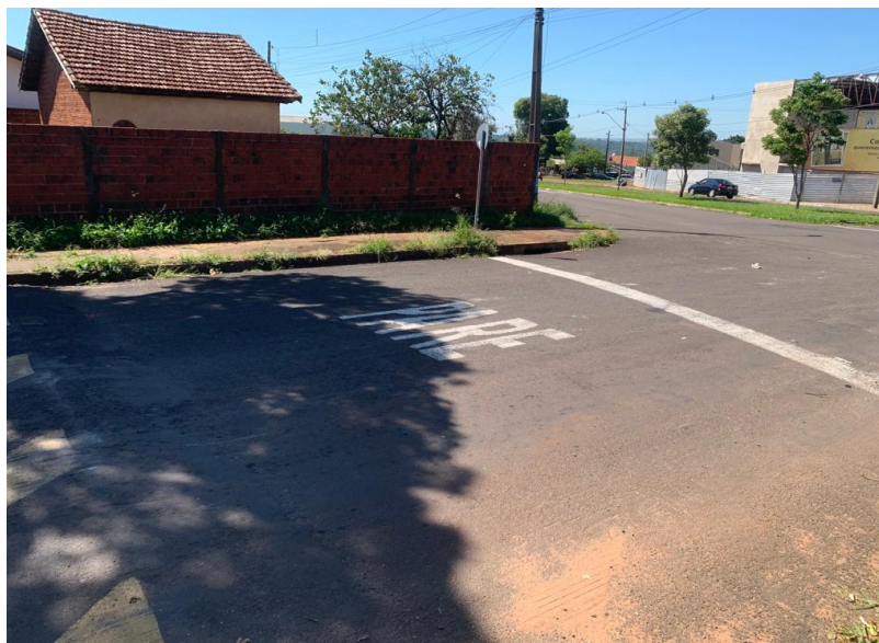
Figura 20: Sinalização horizontal em condição satisfatória
