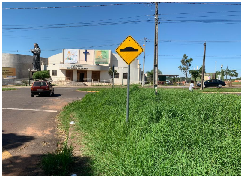
Figura 18: Sinalização vertical em condição satisfatória
