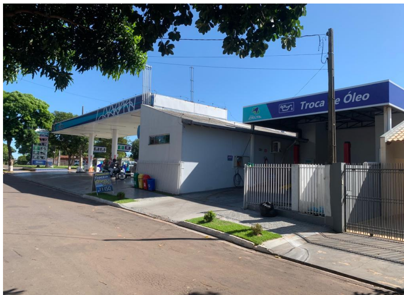
Figura 12: Posto de combustível
