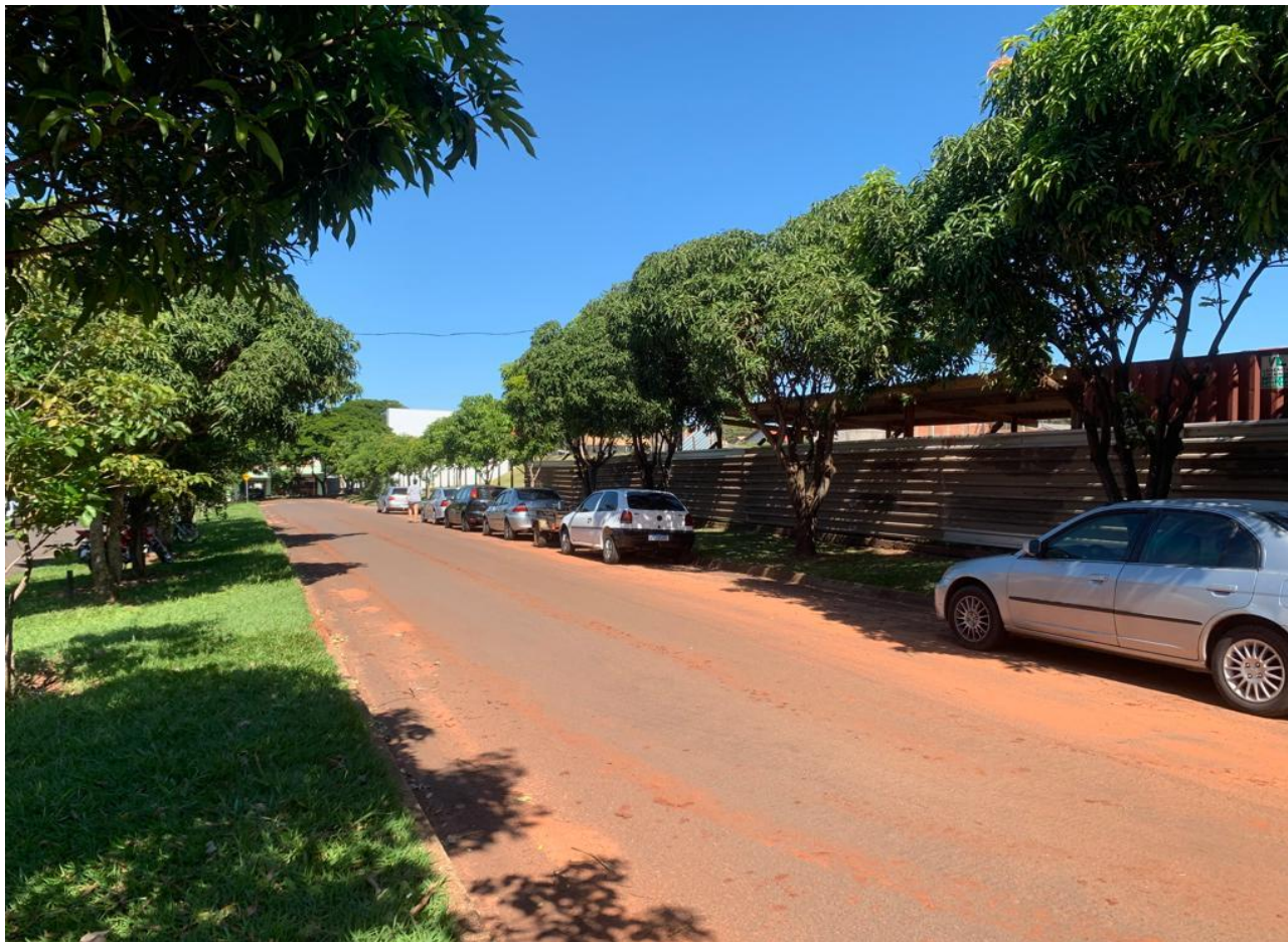
Figura 8: Avenida Francisco Jorge Nacle pavimentada.
