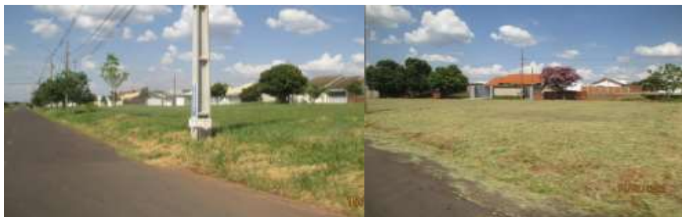
Figura 47. Ausência de calçamento na Av. Ilha do Mel. Fonte: Master Ambiental, 2022.
