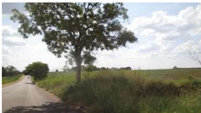
Figura 43. Ausência de calçamento na Av. Atlântica. Fonte: Master Ambiental, 2022.
