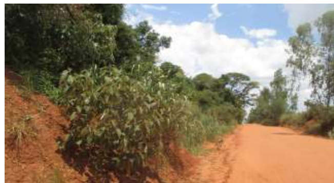
Figura 41. Trecho do prolongamento da Av. Europa com ausência de calçamento. Fonte: Master Ambiental, 2022.
