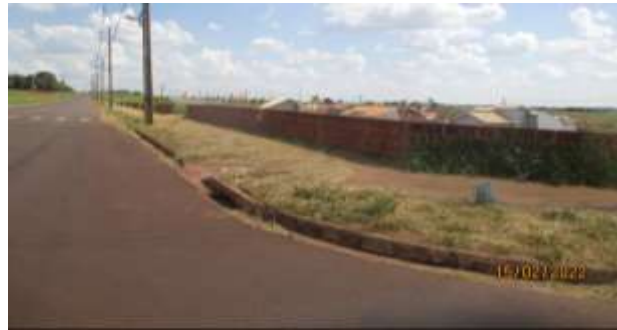
Figura 46. Presença de calçamento na Av Europa, mas sem sinalização podô tátil. Fonte: Master Ambiental, 2022.
