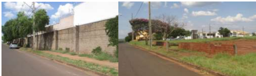
Figura 48. Presença de calçamento na Av Ilha do Mel, mas sem sinalização podô tátil. Fonte: Master Ambiental, 2022.
