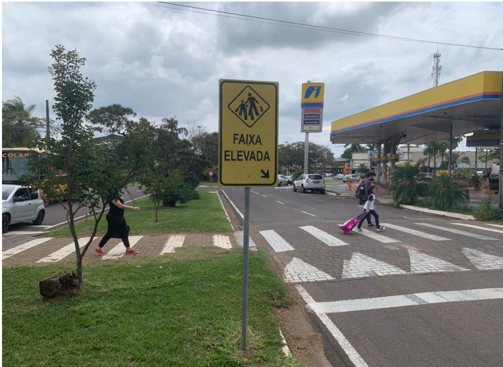
Figura 20: Sinalização vertical em condição satisfatória
