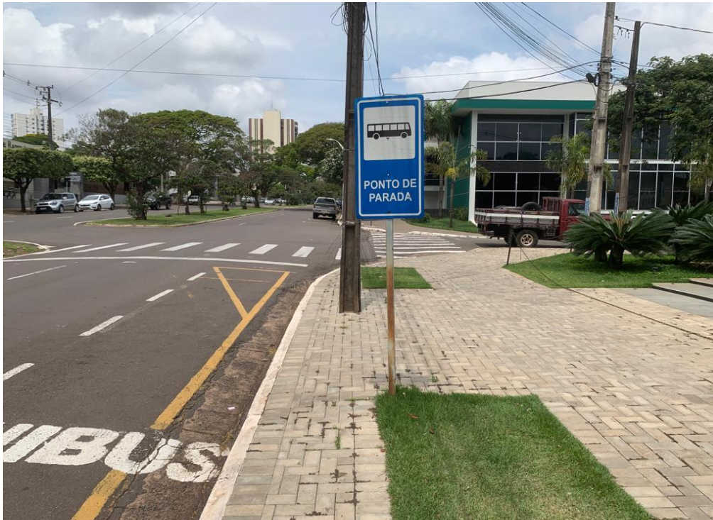
Figura 22: Sinalização vertical em condição satisfatória
