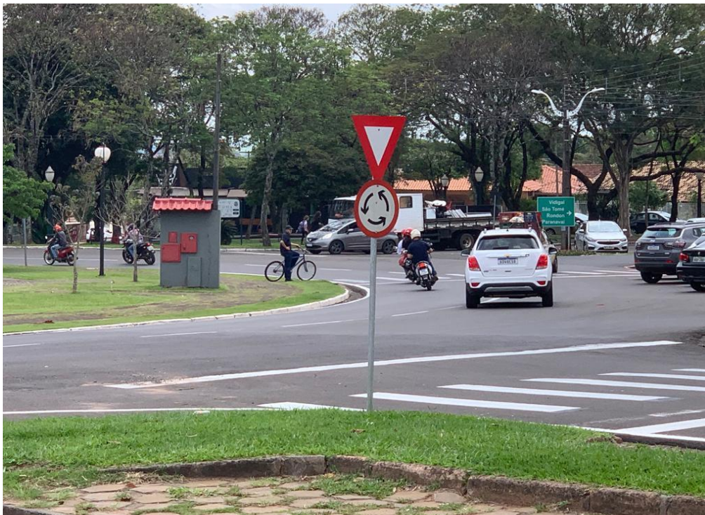
Figura 23: Sinalização vertical em condição satisfatória
