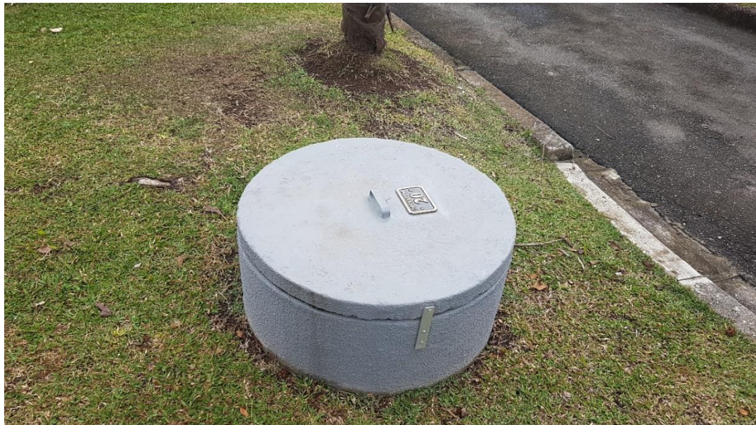
Figura 51 Poço de Monitoramento Cemitério Parque São Pedro, Curitiba, Paraná
