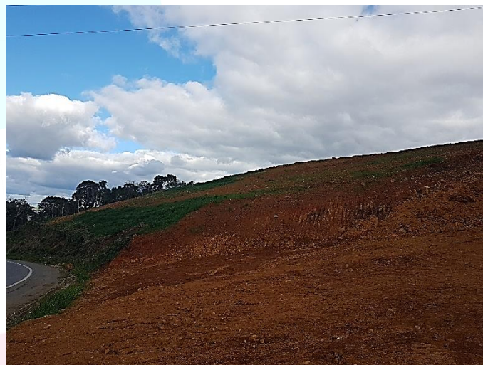
Figura 50 Imagem da frente do terreno, Rua Ladislau Griczynski
