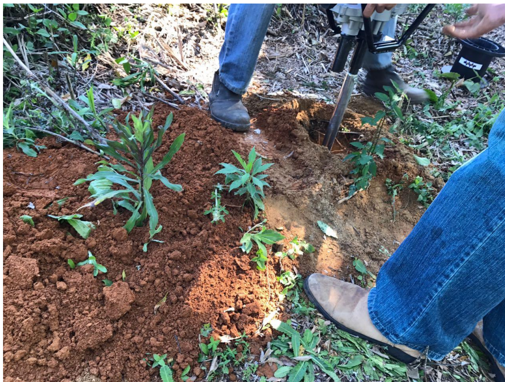
Fotografia 9: Trabalhos de Campo - Furo de sondagem 3 com 5 metros de profundidade.
