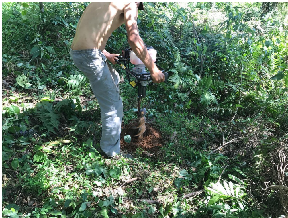
Fotografia 12: Trabalhos de Campo - Furo de sondagem 6 com 0,5 metros de profundidade.
