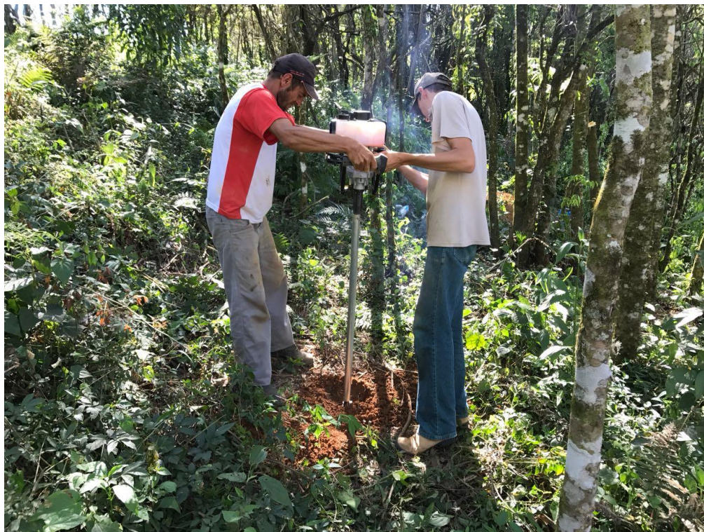
Fotografia 10: Trabalhos de Campo - Furo de sondagem 4 com 8 metros de profundidade.
