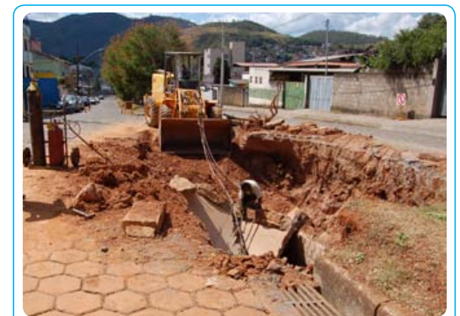
Funcionários da secretaria de Obras realizam reparo na rede pluvial danificada pelas chuvas na avenida Rodrigues Alves, no bairro República. A via e o canteiro central serão revitalizados e o trânsito será normalizado nos próximos dias.
