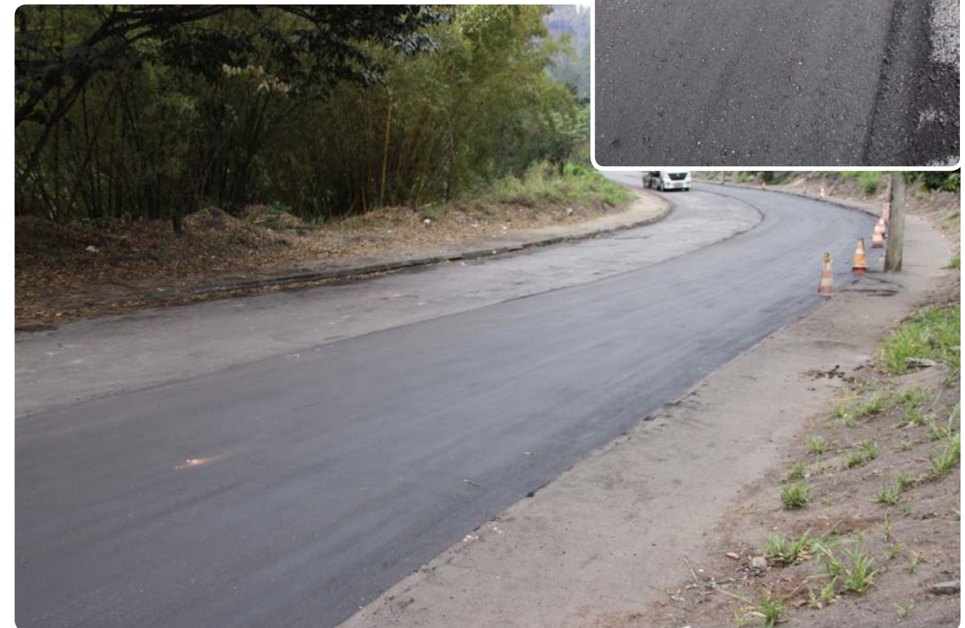
Prefeitura executa a segunda etapa de asfaltamento na avenida Amazonas iniciada no primeiro ano de Governo
