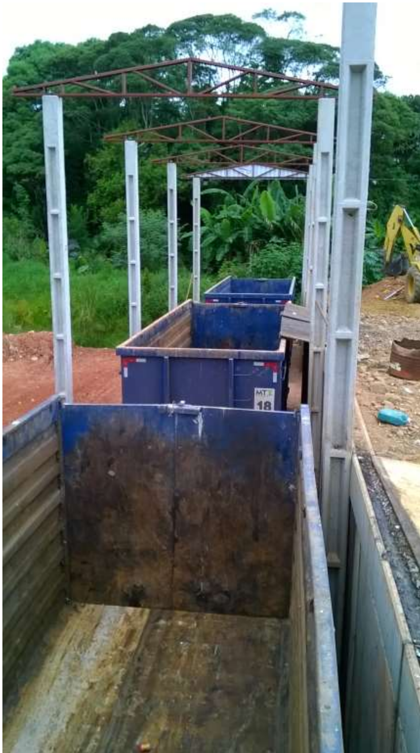
Foto 46: Reajustes na cobertura Fonte Prefeitura Municipal
