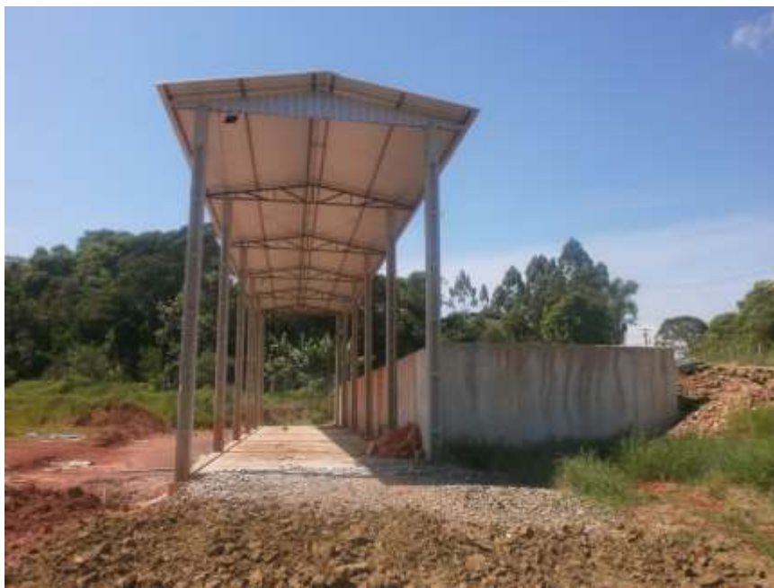
Foto 43: Vista lateral da estação de transbordo em construção Fonte: Prefeitura Municipal
