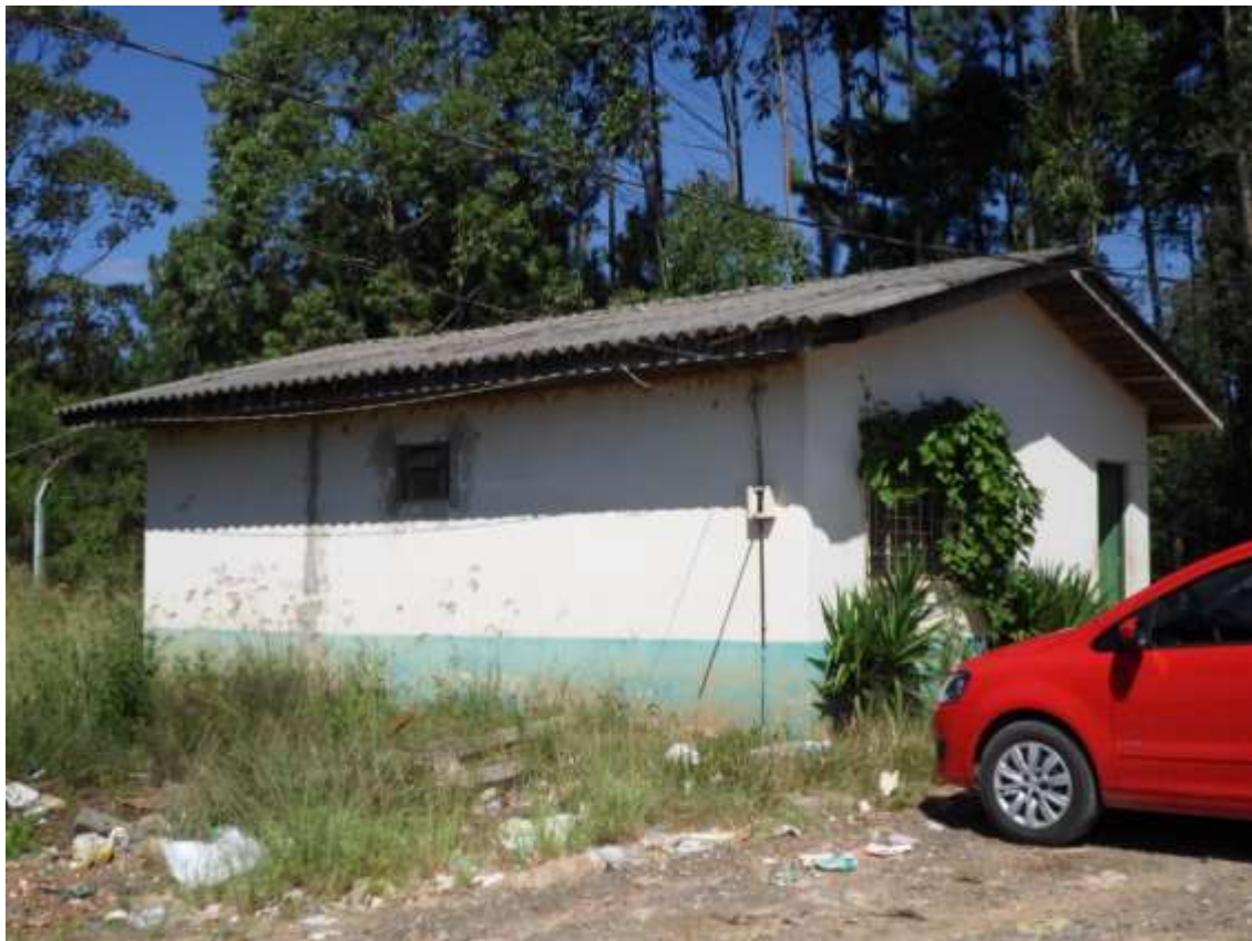
Foto 49: Casa de apoio
