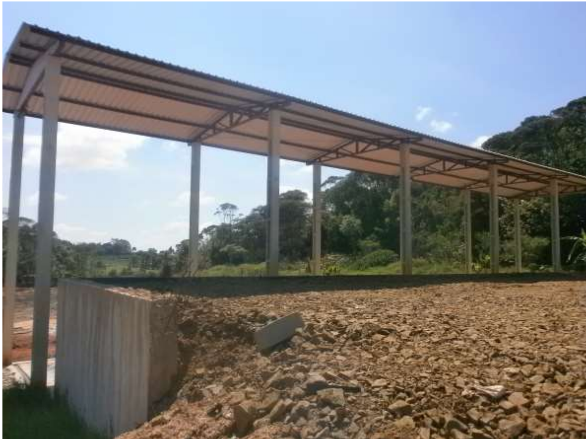
Foto 42: Estação de transbordo em construção
