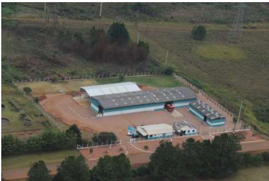
Foto 18: Central de recebimento - Ponta Grossa Fonte: ASSOCAMPOS
