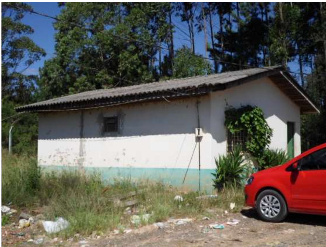
Foto 61: Casa de apoio
