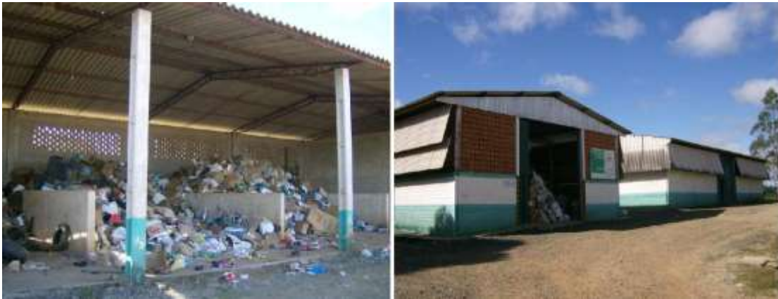
Fotos 39 e 40 : Galpão de Seleção de resíduos e barracão de embalagens de agrotóxicos. Fonte: Kauri.
